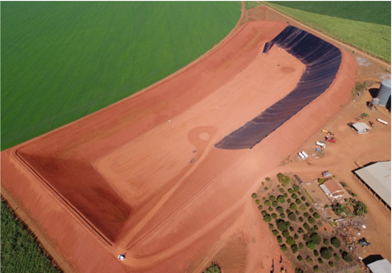
Figura 1 – Exemplo de reservatório enlonado, com 22 m de profundidade
